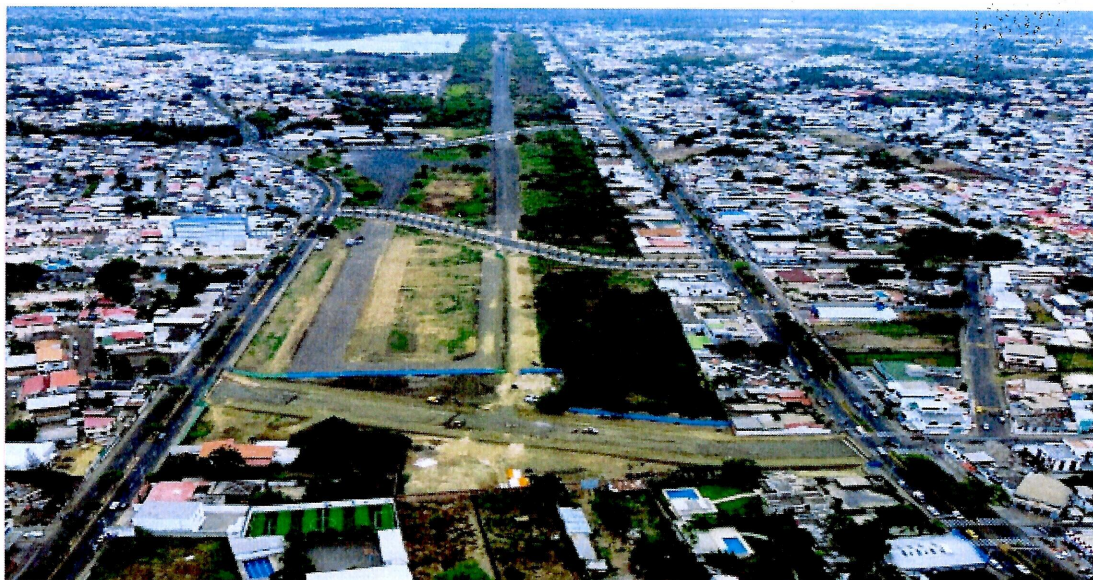
ANEXO 10. Proceso de construcción de la VTO
