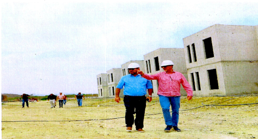
ANEXO 6. Construcción de 38 soluciones habitacionales correspondientes a Bicentenario Etapa 3
